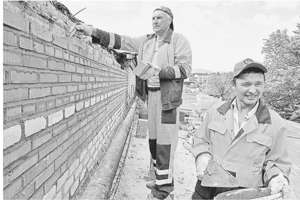
ЕСЛИ ЗЕМЛЮ ТВОРИЛИ БОГИ, МЫ ТВОРИМ ГОРОДА НА НЕЙ! Каменщики Олег Сурков и Нурислам Мурзин производят замену кладки здания компрессорной.
