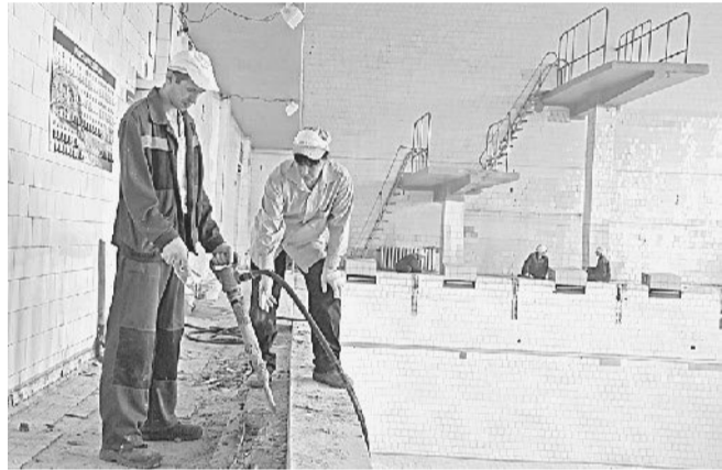
Плотник Антон Брызгин и маляр Елена Асабина ремонтируют ванну бассейна в ФОЦ АО «Златмаш».
