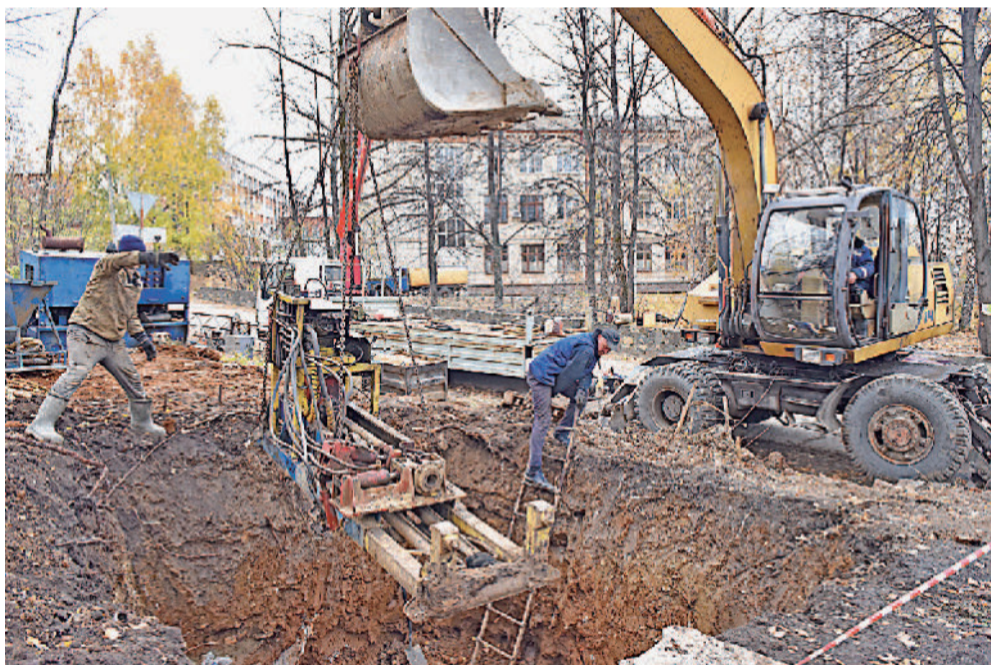
Прокладка кабеля под перекрестком у ЗФ ЮУрГУ.
